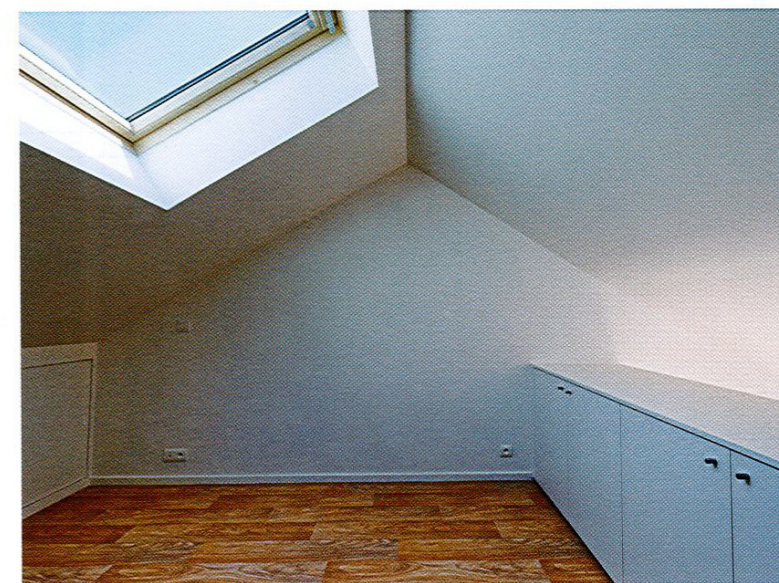
Dans les combles, une mezzanine suspendue à la charpente existante offre une chambre supplémentaire à l'appartement du dernier étage.
