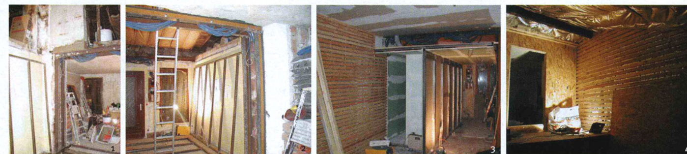
1 - 2 La structure porteuse (en L), conçue par le bureau d'études, est composée de deux poutres HEA 100 reliées par des entretoises. Elle supporte ainsi la partie haute des conduits de cheminée ayant été conservés d'un côté, et est fixée à l'opposé dans le mur porteur. 3 La structure secondaire (en T) est un système de portique composé de cadres de tubes métalliques. Le premier portique monté à la verticale constitue la cloison entre la cuisine et la salle de bains. Le second posé à l'horizontale (fixé dans le mur porteur côté salle de bains et en porte-à-faux côté cuisine) soutient la mezzanine. 4 De la mezzanine, on accède au grenier par une porte directement découpée dans la cloison. Au plafond apparaît l'isolant mince Actis avant d'avoir été recouvert avec les linteaux.
